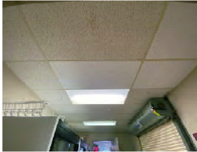
INT011 - Bar Ceiling
