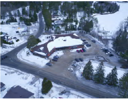
SITE031 - Site Overview
