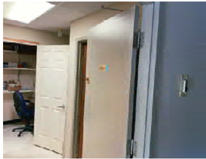
INT050 - Janitor Storage Door
